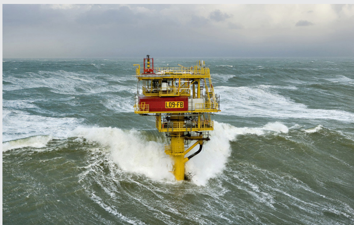
FIGUUR 1 Een "monopile"-platform in zware golven.
