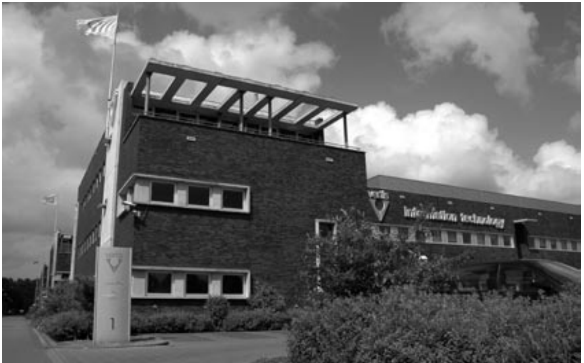
Het pand van Vertis in Groningen
