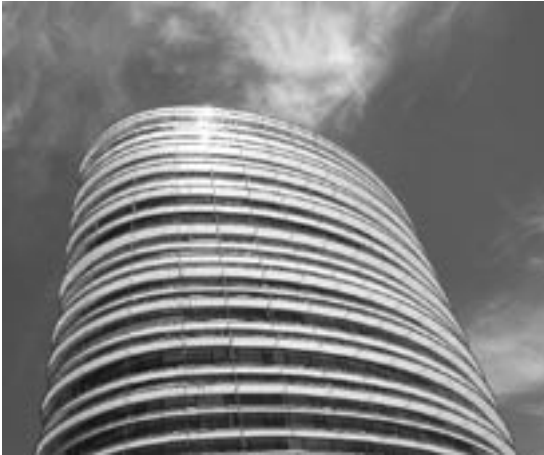
Het zestien verdiepingen tellende Walterbosch-complex van de Belastingdienst in Apeldoorn
