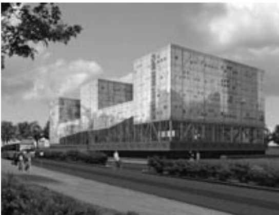
Achterkant FBOR-gebouw, gezien vanaf de Zonnelaan
